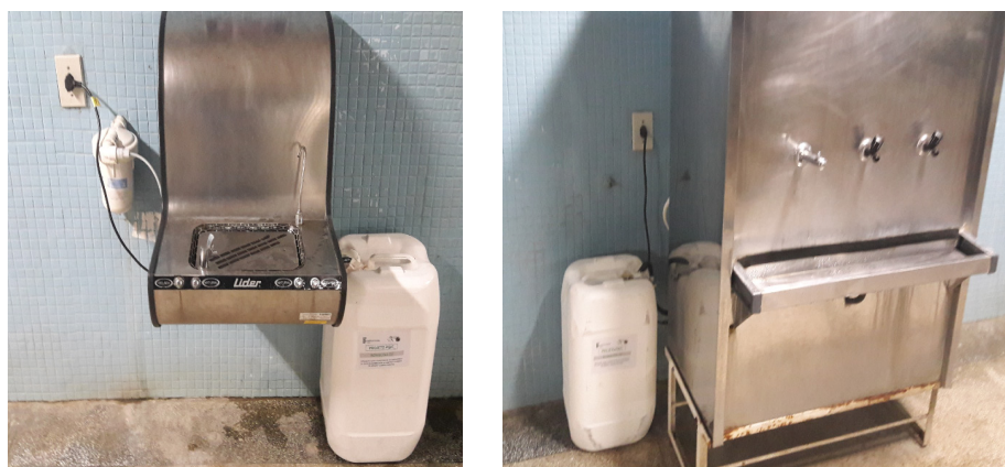
Figura 2. Recipiente acoplado aos bebedouros para coleta da água desperdiçada.
