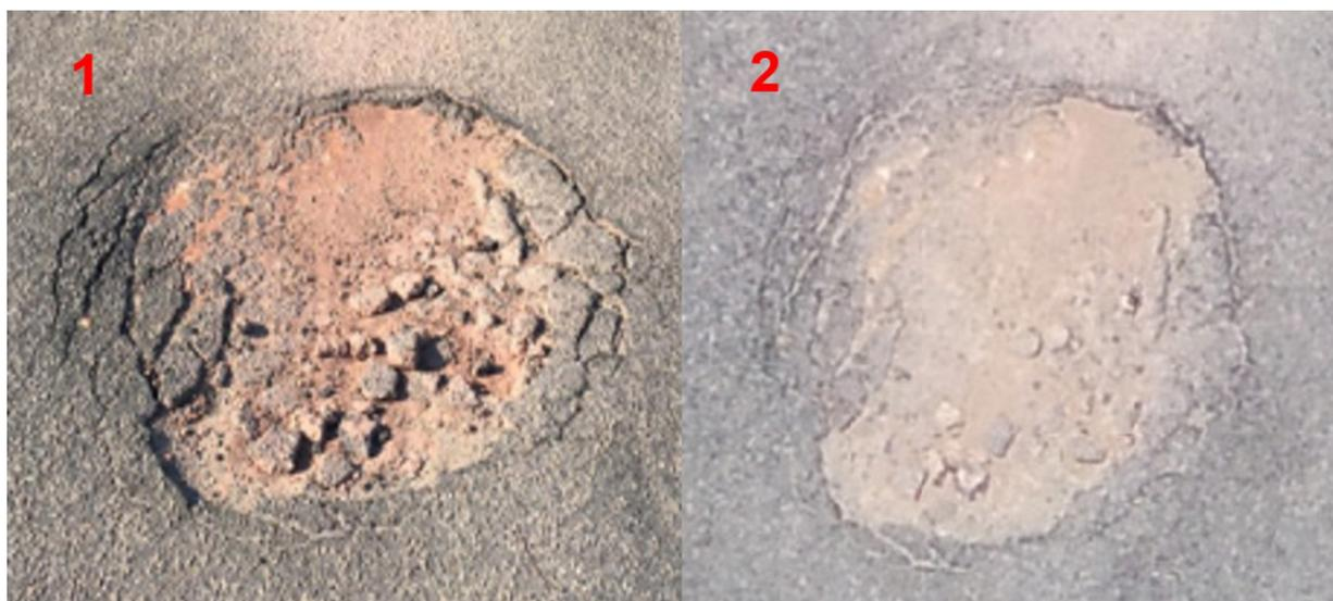
Figura 3. Comparação entre imagens de panelas.
