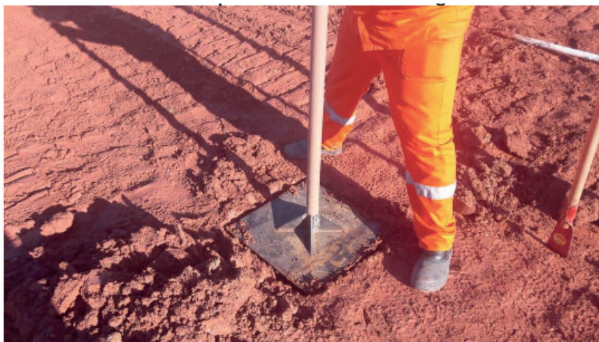
Figura 3-Placas de recalque distribuídas ao longo do trecho da obra.
