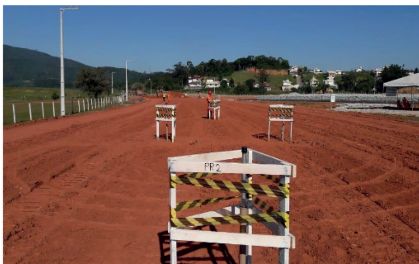
Figura 4-Placas de recalque distribuídas ao longo do trecho da obra.
