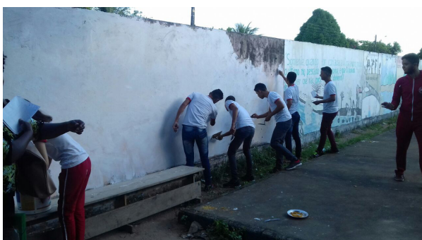
Fig.5 Preparação para pintura do muro
