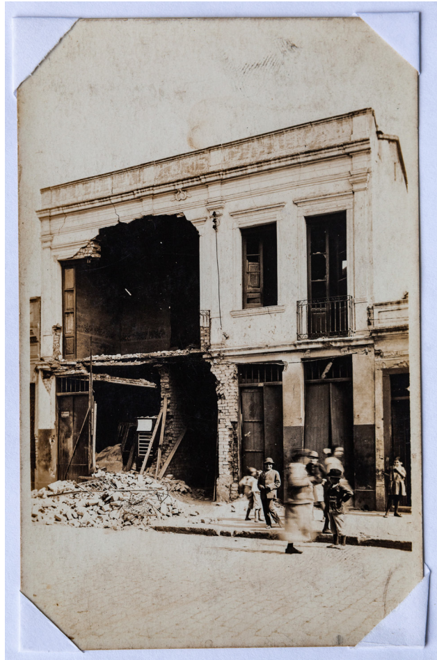
Figura 4 – Fachada de casas destruídas pelos ataques.
