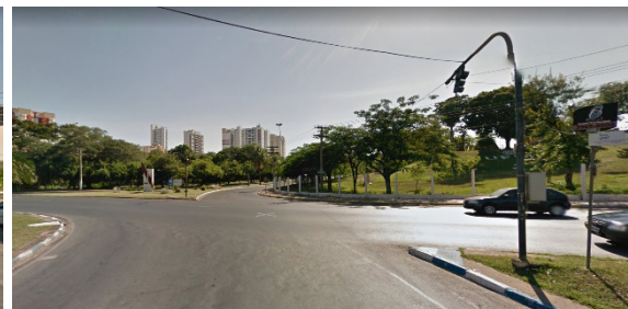
Figura 3 - Acesso à UFMT antes da obra
