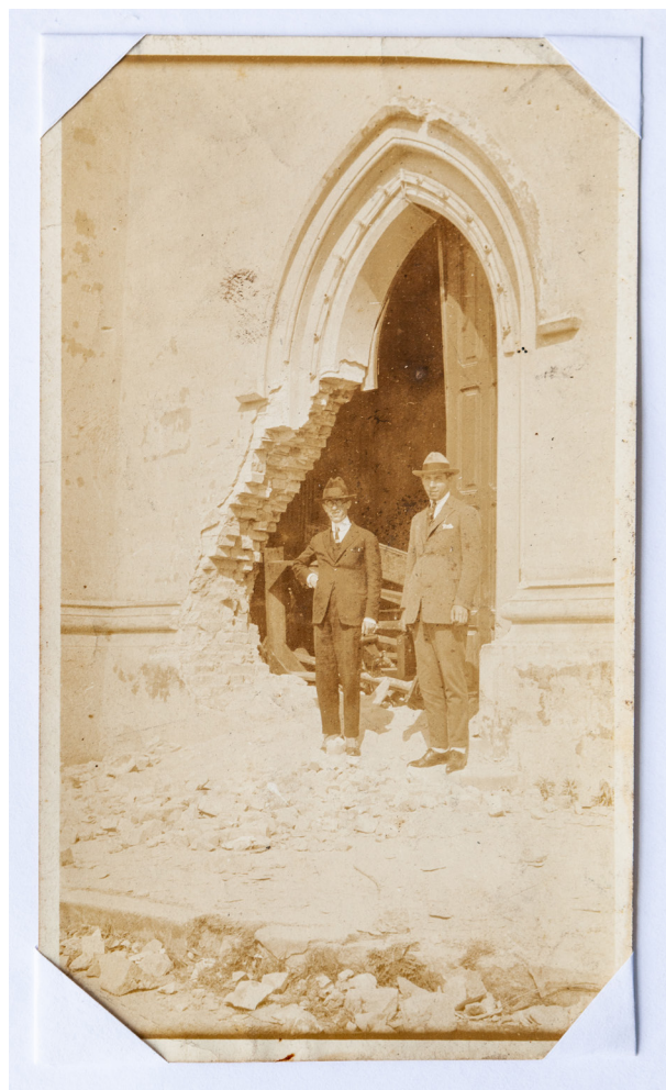
Figura 2 – Dano causado por bombardeio
