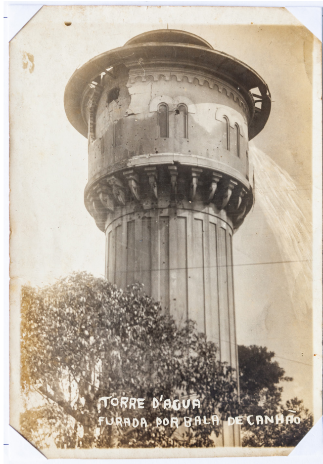
Figura 3 – Torre d'água furada por bala de canhão
