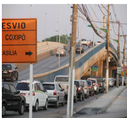
Figura 10 - O trânsito no viaduto.
