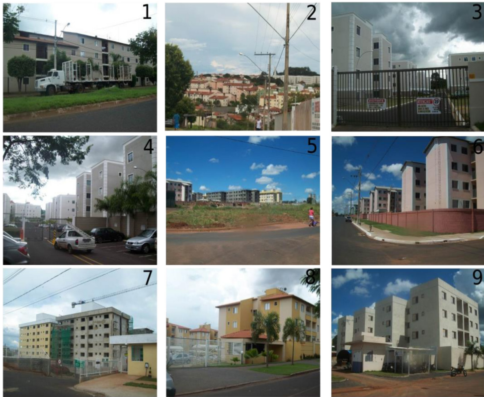
Foto 1 – Condomínio Bela Vista / Foto 2 – Condomínio “EMBRA”
