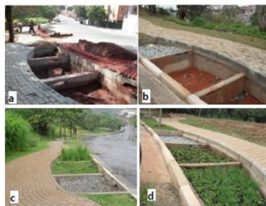
Figuras 4 – Planta de jardim de chuva; Figura 5 – Fotos do jardim de chuva em obra (a, b) e já implantado (c,d). Fonte: PMSP/DEPAVE, 2012.
