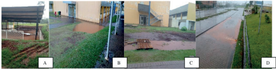
Figura 5 - (A) entrada de solos e água na parte lateral do restaurante universitário. (B) pontos de alagamentos na frente do bloco L. (C) área de alagamento na frente do bloco N. (D) estacionamento principal da universidade.
