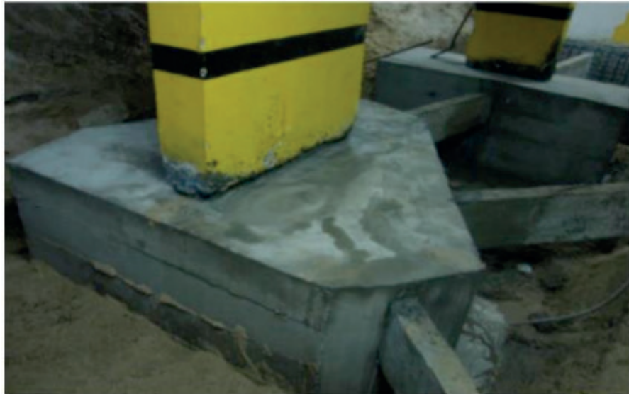
Figura 7 – Bloco finalizado e impermeabilizado
