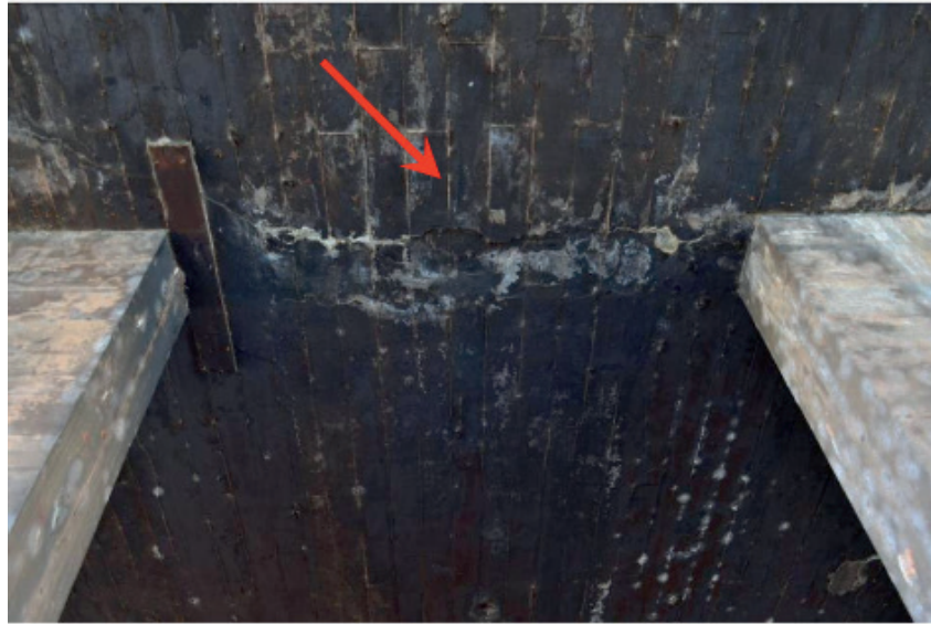
Figura 3.5: Parte inferior da ponte entre pilares.
