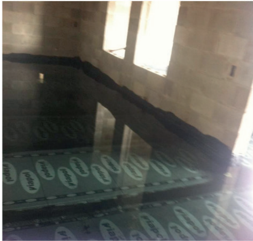
Figura 8 - Carregamento da laje (manta e água).
