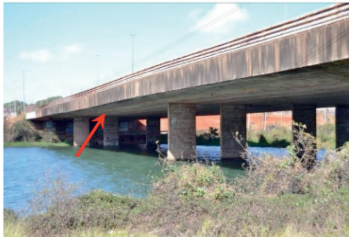
Figura 3.4: Lateral da ponte sobre o lago.
