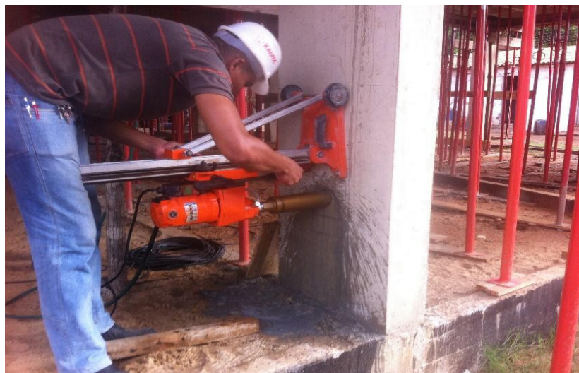
Figura 5 – Início da extração dos testemunhos cilíndricos
