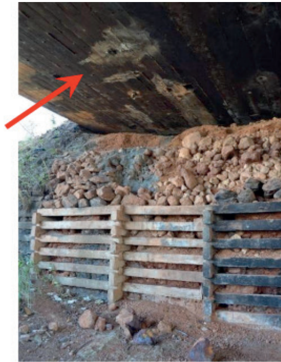
Figura 3.1: Parte inferior da ponte na ligação da ponte com o terreno.
