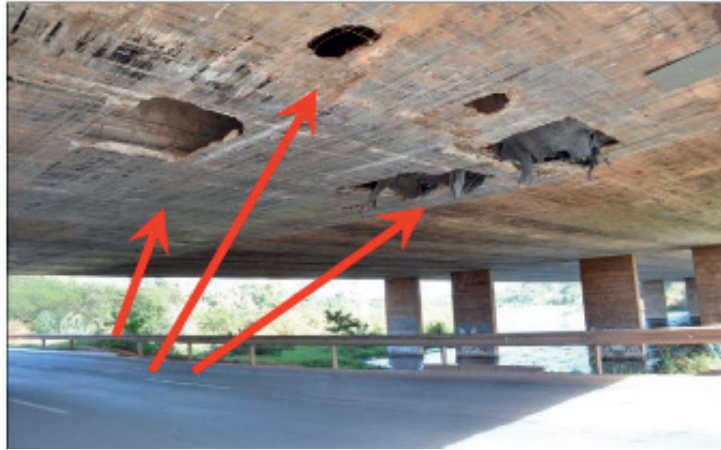
Figura 3.2: Parte inferior da ponte.
