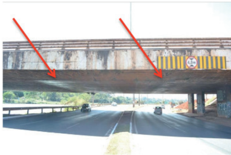
Figura 3.7: Parte inferior da ponte sobre a pista.
