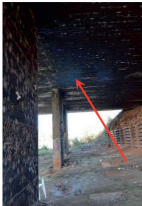
Figura 3.3: Parte inferior da ponte.
