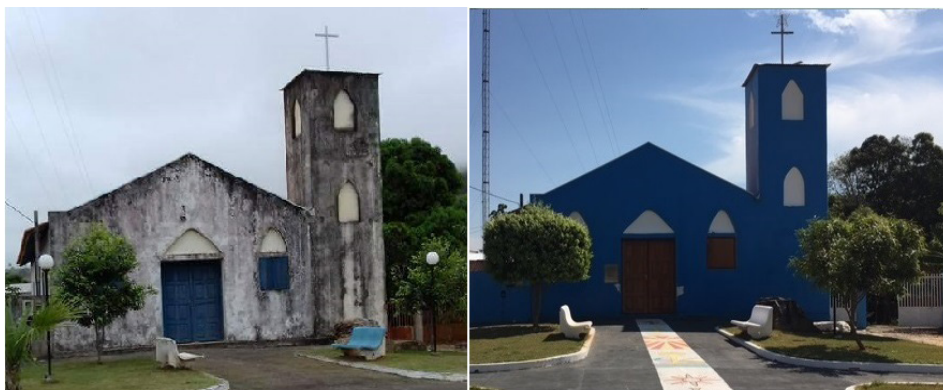
Igreja velha da paróquia Nossa Senhora da Penha/Salto do Céu-MT.
