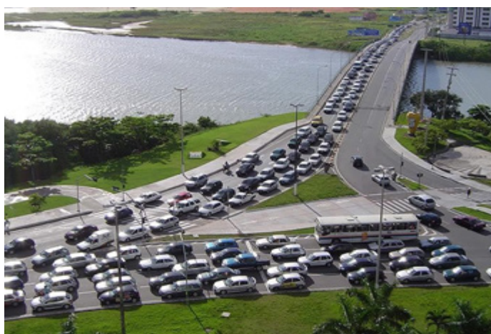
Figura 1 - Ponte da Coroa do Meio.
