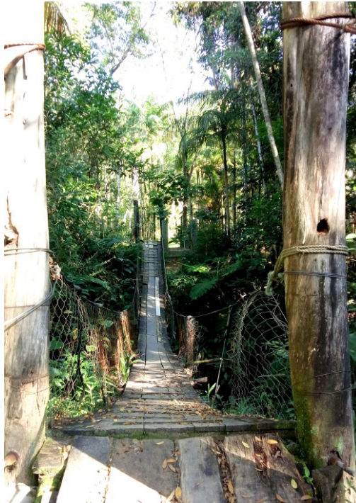
FIGURA 2 – Acesso aos moradores na Comunidade do Parati
