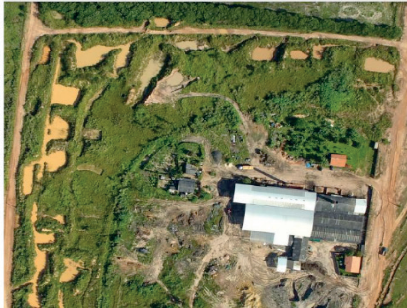
Figura 3. Caixas de contenção. Fonte: PMC – MT (2017).
