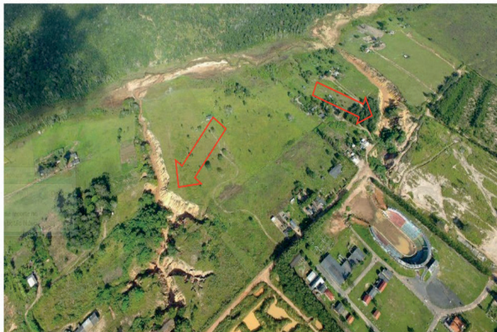
Figura 2. Voçoroca das Marias à esquerda e Buracão à direita. Fonte: PMC-MT (2017).
