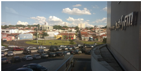
Figura 14 - Painel de ACM na fachada do shopping contrastando com a área residencial térrea do outro lado da rua e criação da rotatória alterando todo o fluxo viário
