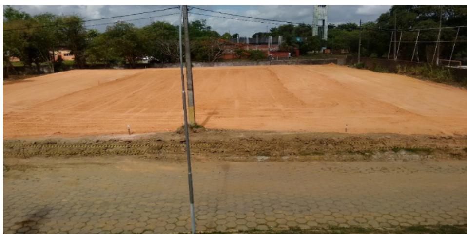
Figura 07 - Terraplanagem concluída da Edificação
