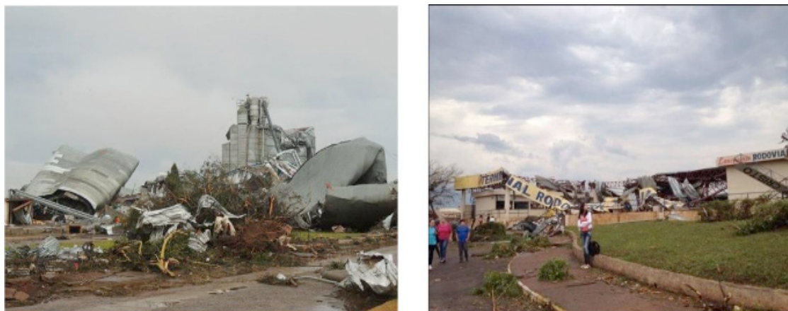
Figura 8. À esquerda, escombros da Igreja do Evangelho Quadrangular e, à direita, terminal rodoviário destruído
