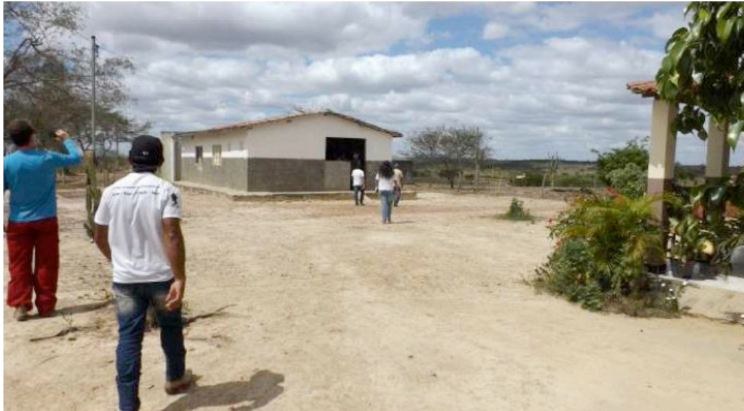
Figura 5 – Escola construída pelo município de Pedro Alexandre (BA) na localidade Couros, porém, abandonada, por ser reconhecida em território de Monte Alegre (SE).
