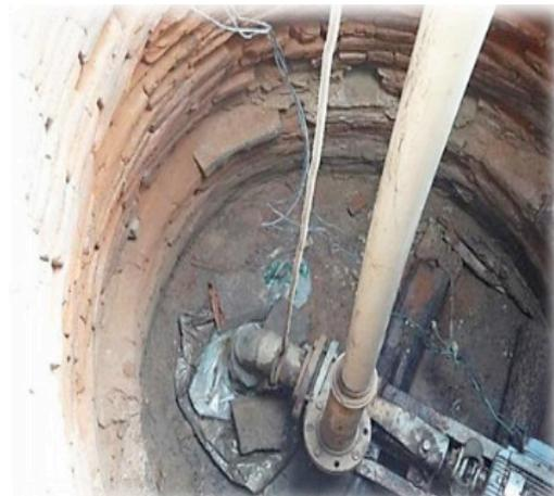
Foto 03 – Poços misto de tijolos/anéis pré-moldados
