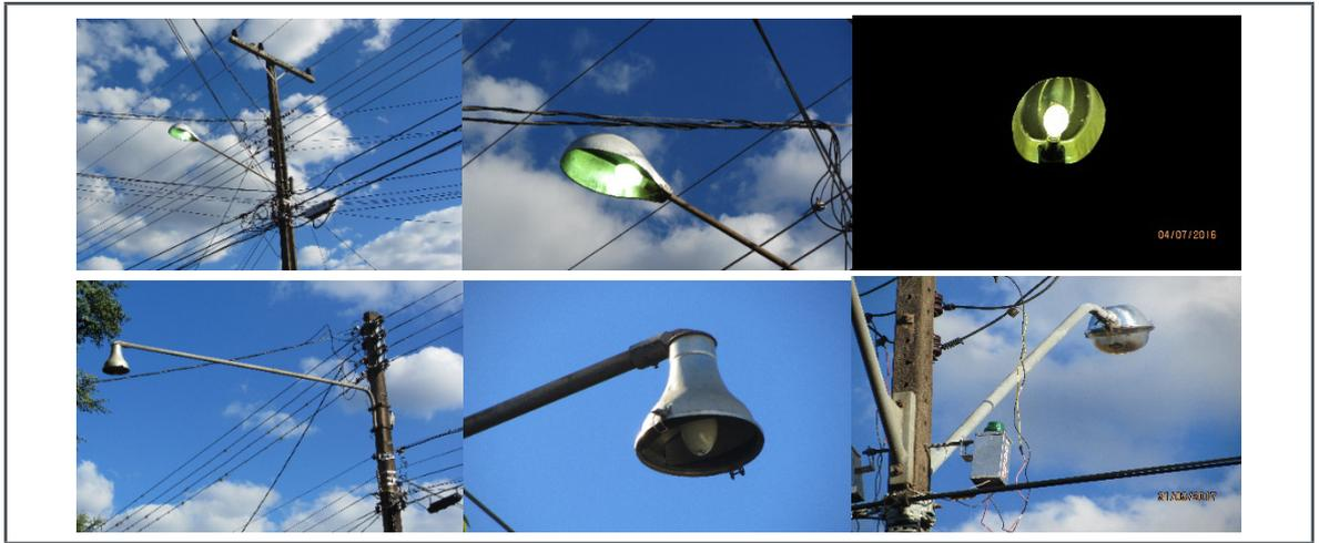
Figura 2 – Luminárias obsoletas (sem óptica definida) com lâmpada vapor de mercúrio
