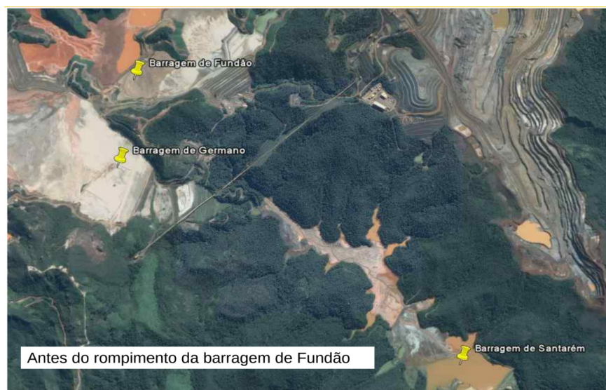
Figura 1: Imagem de satélite antes do rompimento da barragem de Fundão.
