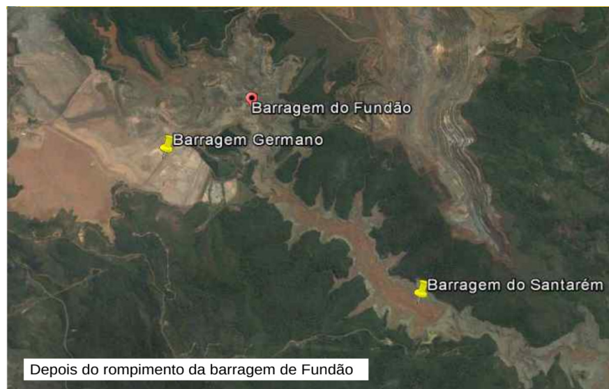
Figura 2: Imagem de satélite depois do rompimento da barragem de Fundão.
