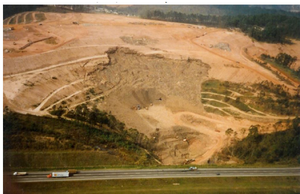
Figura 1. Escorregamento do aterro de Bandeirantes em 1991, (ITP, 1991).
