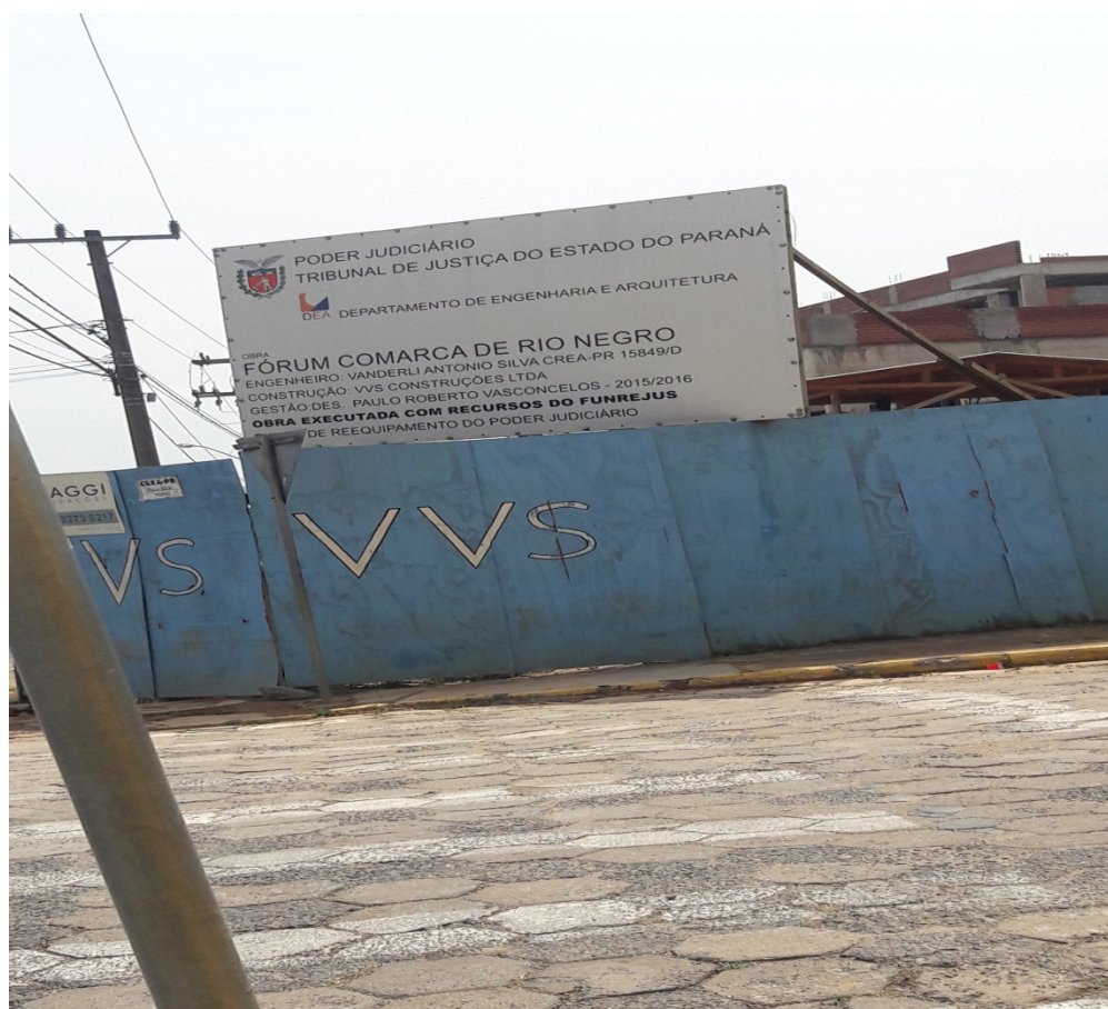
Figura 04: Local da Obra.
