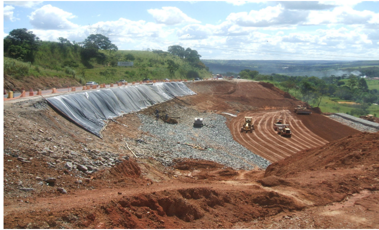
Figura 15. Execução do colchão drenante.
