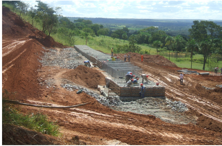
Figura 20. Execução da contenção em gabião.
