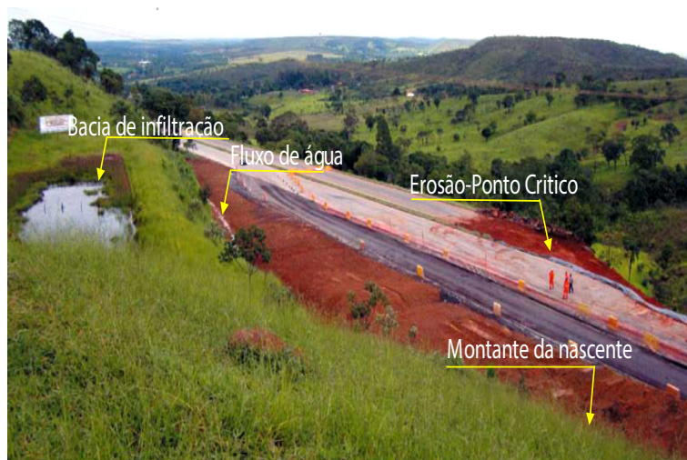
Figura 7. Bacia de infiltração a montante da rodovia (Lino, 2016).
