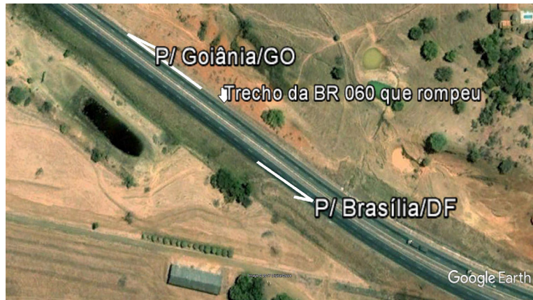
Figura 2. Trecho rompido da BR-060/GO (31/12/2010).
