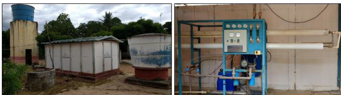
FIGURA 1 - Imagem do sistema desativado da Comunidade Angicos e do dessalinizador por osmose reversa.
