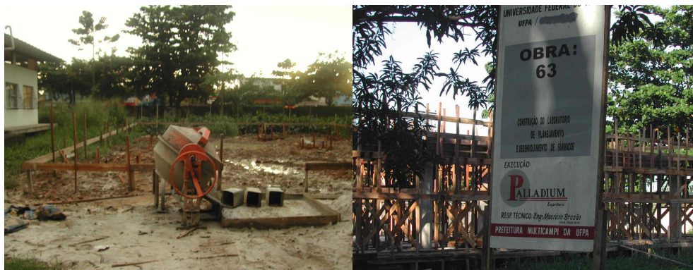
Canteiro da obra
