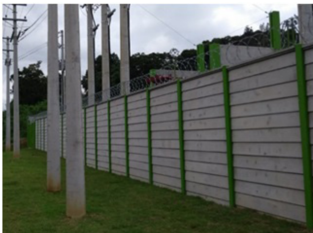
Figura 4: Muro periférico pré-fabricado aplicado na subestação
