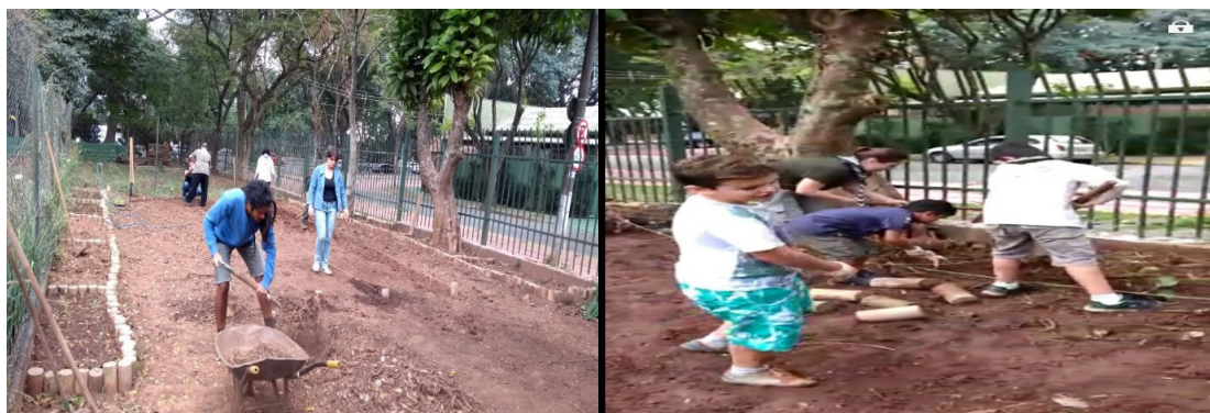
Figura 3 – Construção da infraestrutura da horta do parque Previdência (acervo do pesquisador 09\06\2017).
