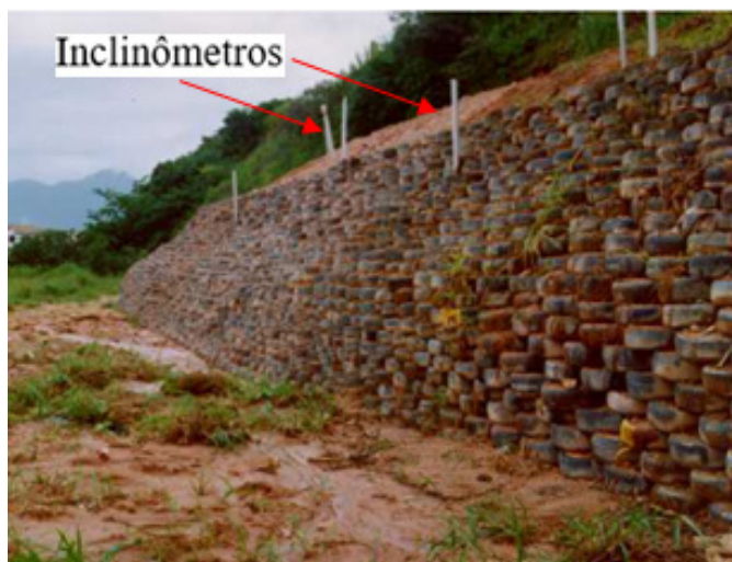
Figura 4. Muro de solo-pneus executado e inclinômetros aparentes na face do talude (Sieira, 2001)
