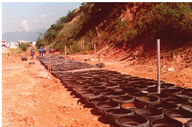
Figura 2. Lançamento da primeira camada de pneus na superfície (Sieira, 1998)
