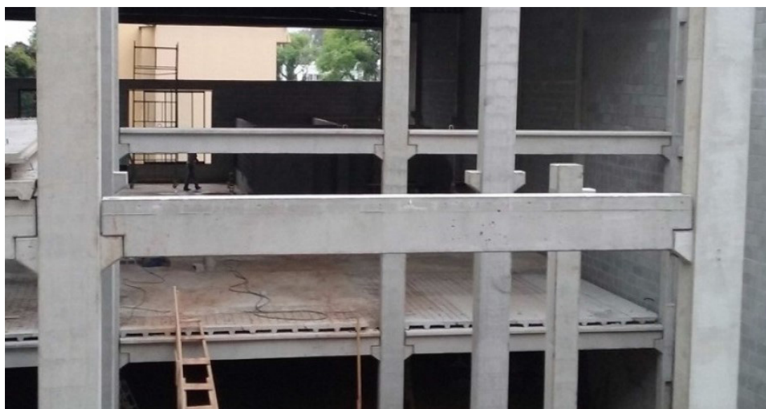
Figura 3 - Viga típica de concreto armado pré-fabricada.
