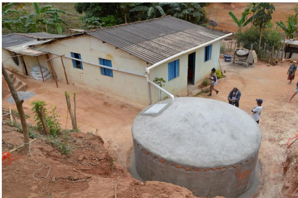
Figura 2 – Sistema de captação de água da chuva.
