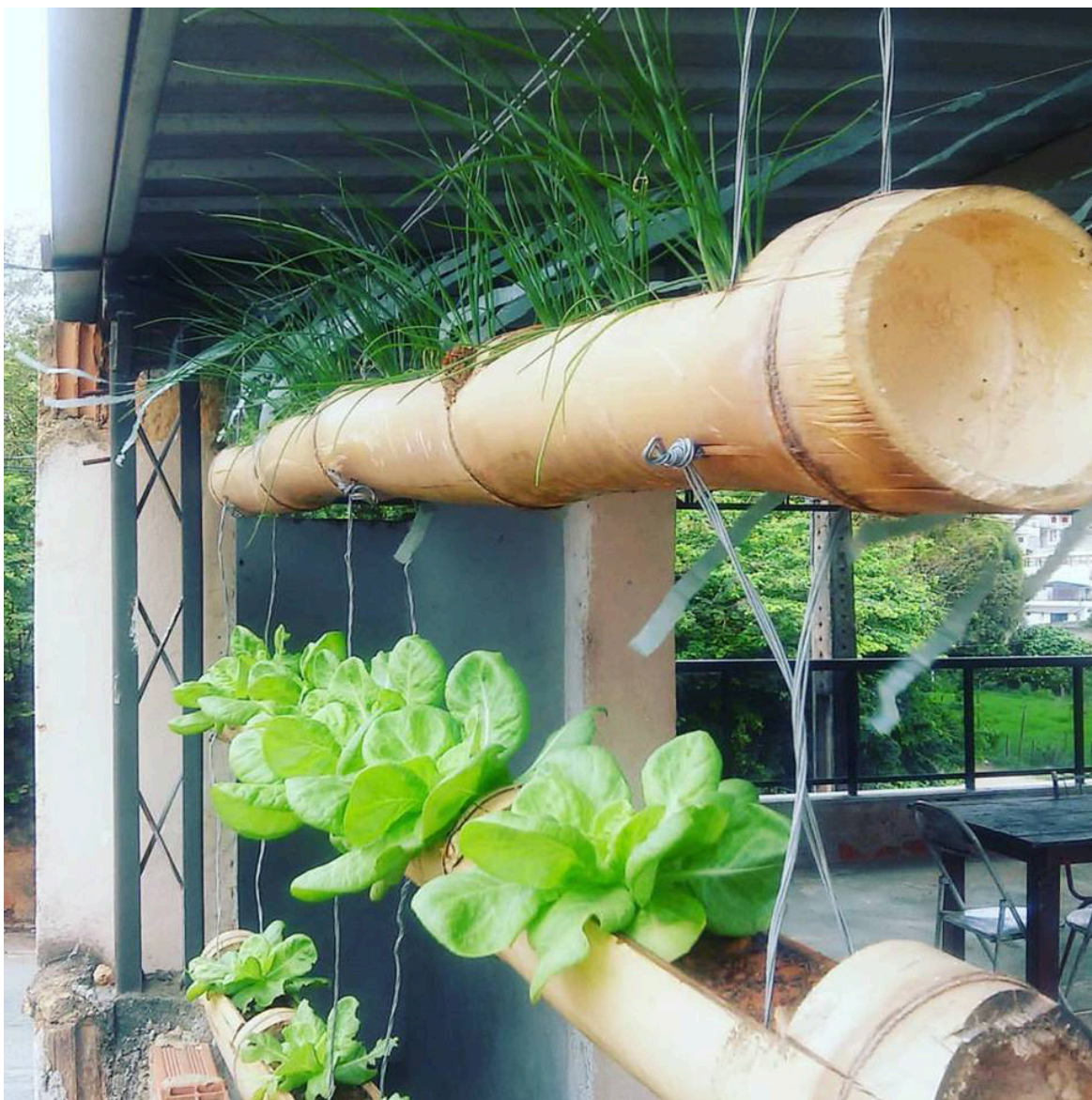
Figura 1B: Estrutura de bambu gigante, para implantação em uma das residências contempladas com o projeto.
