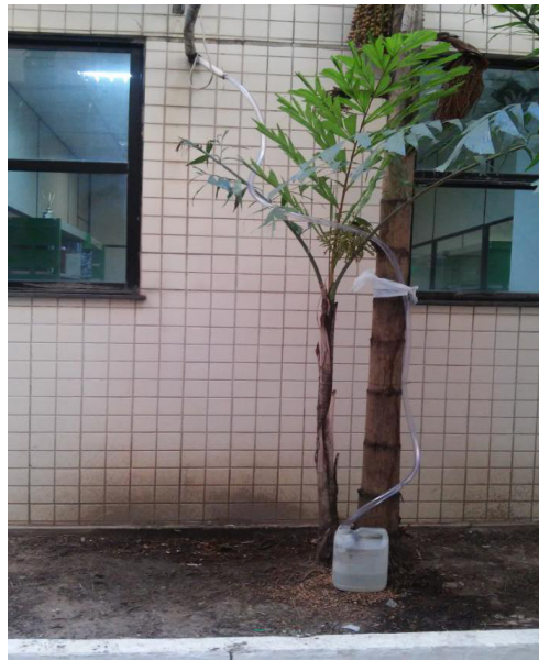
Figura 2: Coleta para medição da vazão de água dos condicionadores de ar do tipo Split.
