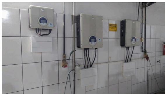
Figura 4: Inversores que compõem a parte interna do sistema fotovoltaico do estabelecimento comercial, São Gabriel – RS, 2018. Fonte: Autores, 2018.
