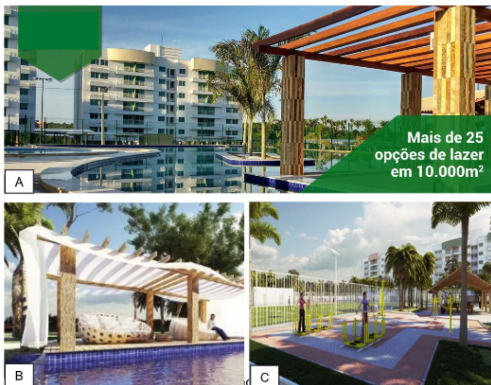
Figura 2 – Condomínio clube em Teresina / PI.
