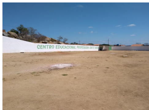
Figura 02. Fachada (parte interna)
