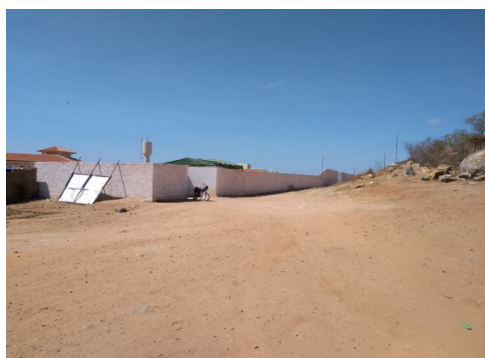
Figura 01. Fachada (parte externa)
