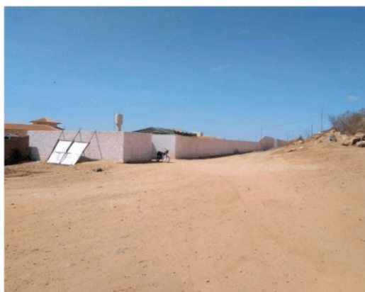
Figura 01. Fachada (parte externa)
