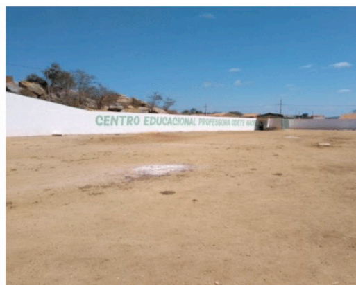
Figura 02. Fachada (parte interna)
