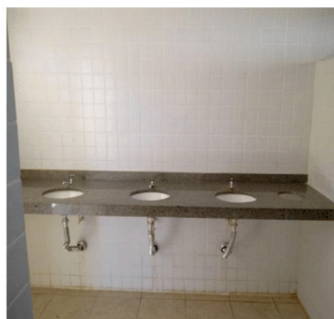
Figura 08. Pias do Banheiro dos Alunos
