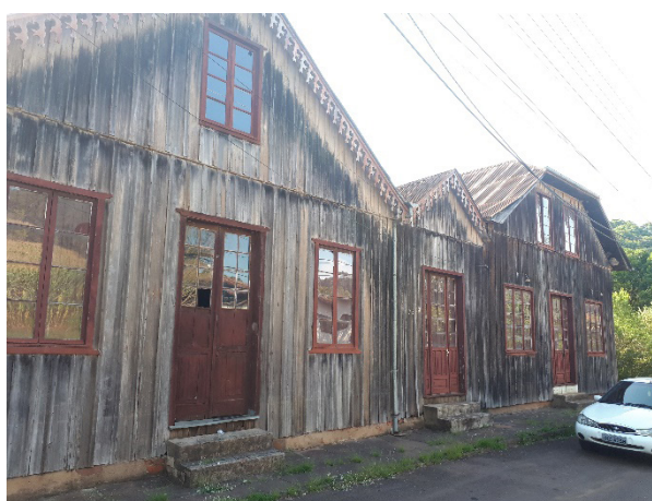
Figura 6– Casarão e Moinho da família Pulga, construções em madeira de araucária edificadas no fim do século XIX, representantes da influência da imigração italiana na arquitetura da região.
