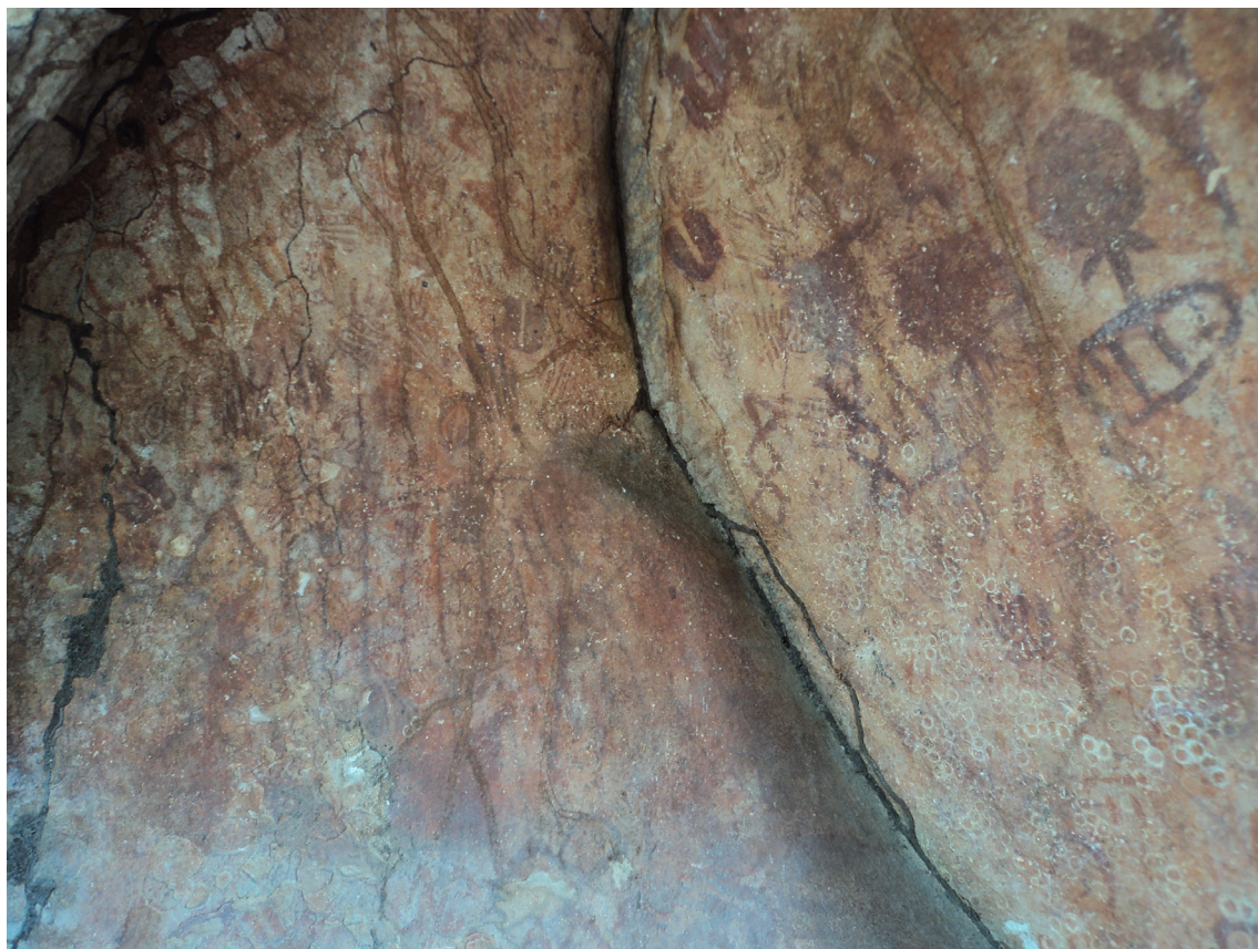
Figura 6: Problemas de conservação afetando as pinturas rupestres do sítio Tamboril: eflorescências salinas, galerias de cupins, manchas deixadas por galerias de cupins e resíduos de ninhos de vespas. Fotografia: LCD Cavalcante.
