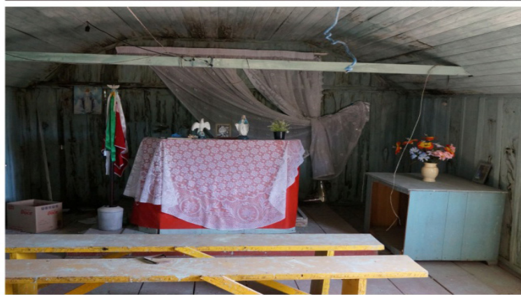
Figura 8: Vista interna da capela.
