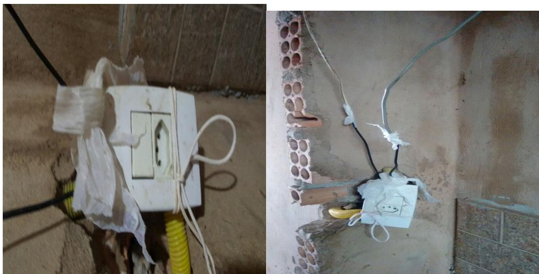
Figura 7. Tomada e interruptor presos por fio
