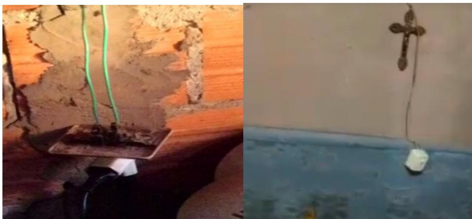
Figura 5. Tomada exposta e interruptor sem fixação
