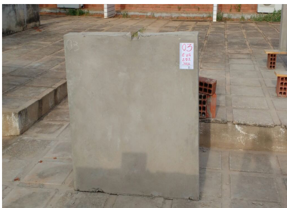
Figura 2: Parede de alvenaria com 2,50% de adição de EVA
