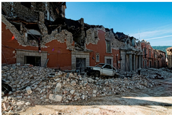
Figure 2- O terremoto em Áquila (Dipartimento Della Protezione Civile)
