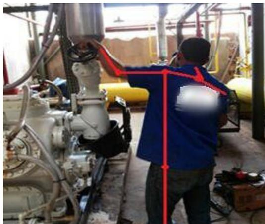
Figura 7 – Liberando a válvula do compressor de amônia
