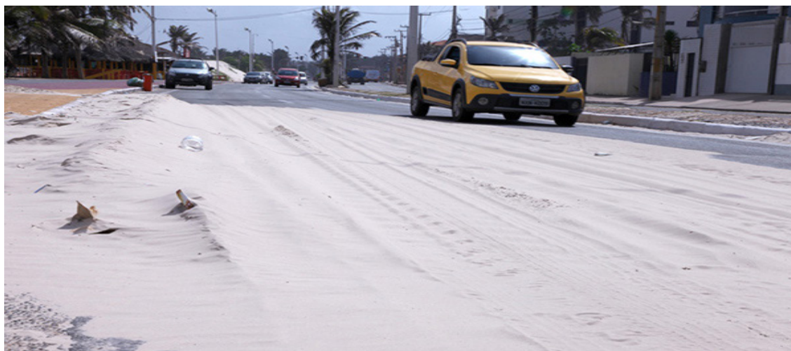
Figura 6: Acúmulo de areia na Avenida Litorânea, São Luís/MA, causado pela intensificação do processo de movimentação das dunas. Fonte: Imirante, 2015.
