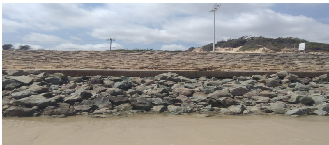
Figura 5: Enrocamento ao longo da Avenida Litorânea, São Luís/MA.
