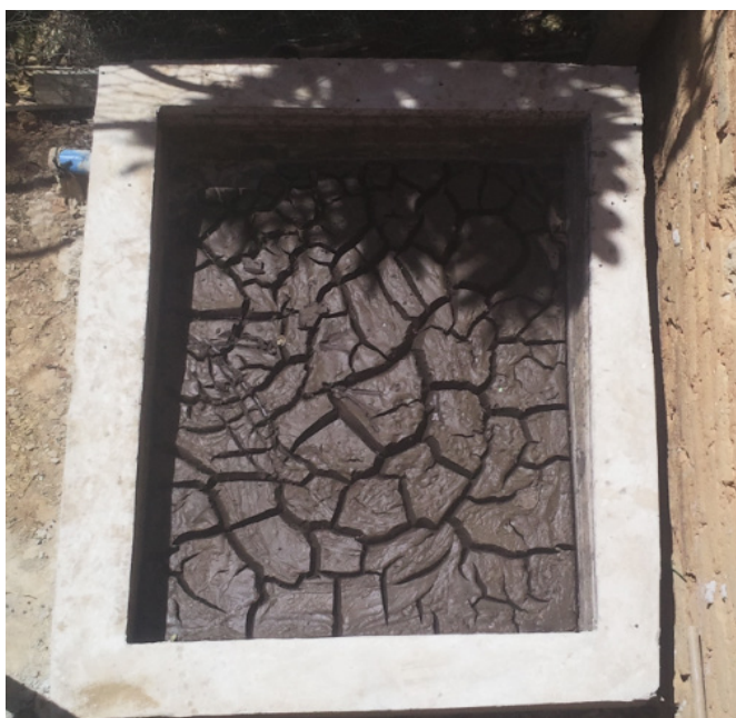
Figura 4: Água antes e depois do processo e o leito de secagem para desidratação do efluente.
