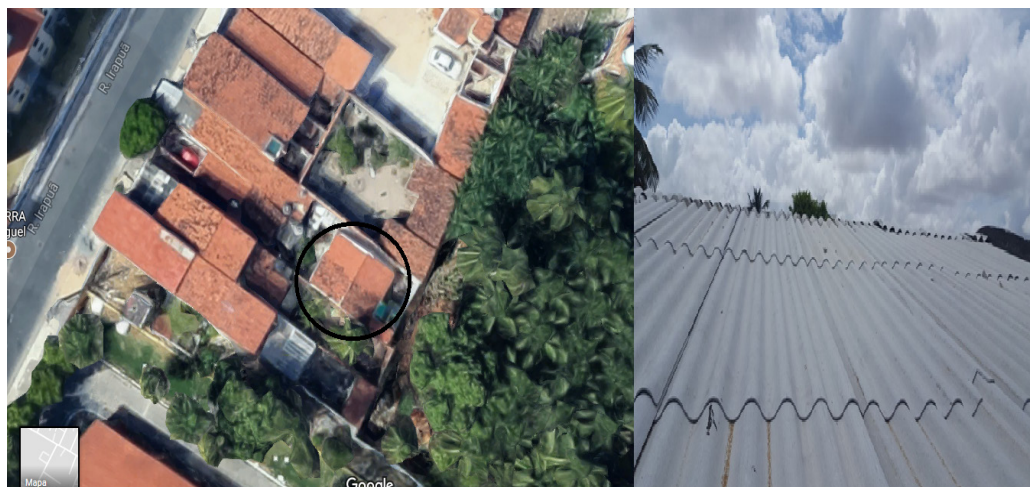
Figura 02 - Vista superior do telhado da residência
