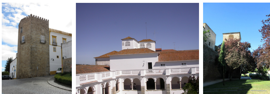
Fig. 32 – Torre das Cinco Quinas, uma das torres de construção mais remota.
