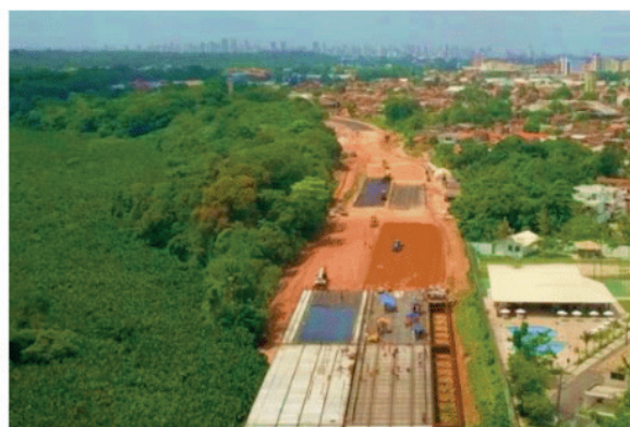
Figura 2. Av. João Paulo II – localização do canteiro.
