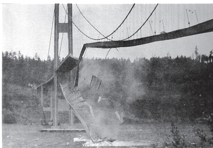
Figura 1. Colapso da ponte Tacoma – EUA.
