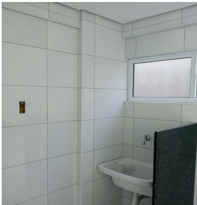
Figura 4 – Detalhe de maior utilização de recortes na obra A.
