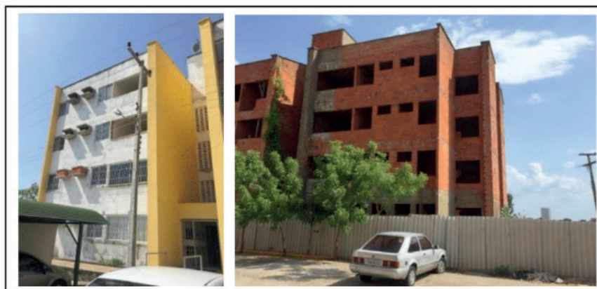
Figura 2: Edifício em alvenaria estrutural no Piauí
