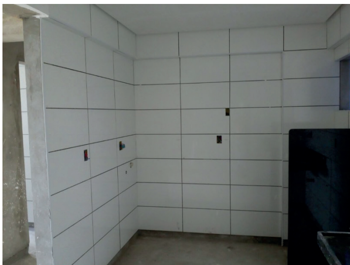
Figura 1 – Paginação do revestimento cerâmico na obra B.
