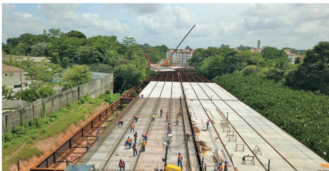
Figura 4. Sequência de voo, tipo varredura na ponte sobre Água Preta.
