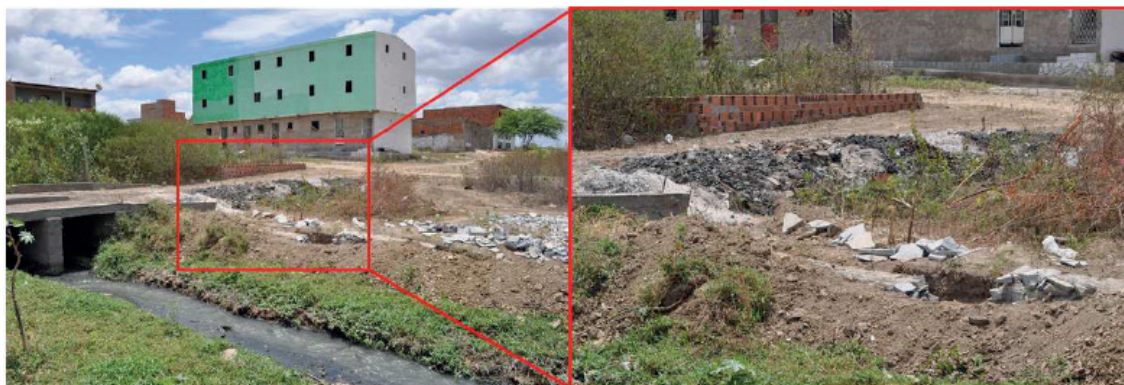
Figura 6 - Descarte indevido dos resíduos provenientes das lavanderias.
