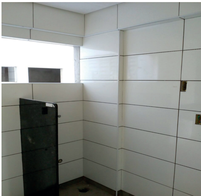
Figura 2 – Detalhe de maior utilização de peças inteiras na obra B.
