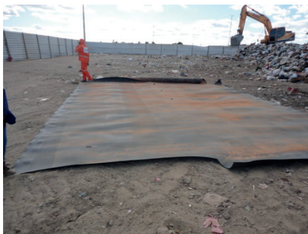
Figura 2. Manta plástica para confinamento dos resíduos
