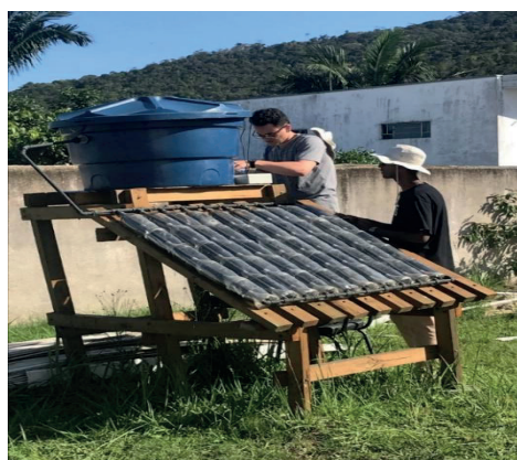
Figura 05: Bolsista do Projeto Aquecedor Solar com Materiais Recicláveis ajustando o Arduíno para realizar as medições
