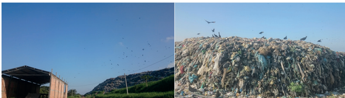
Figura 3: Consócio Intermunicipal Aterro Sanitário em Pontal do Paraná.
