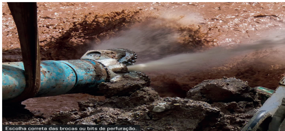
Figura 6 – Detalhe da broca de perfuração.
