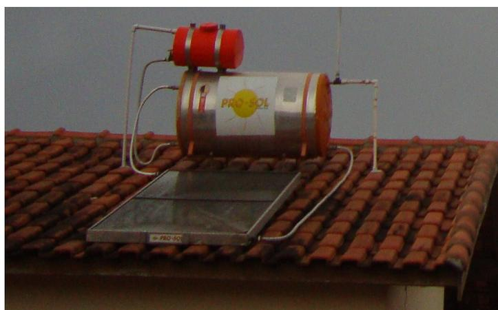
FIGURA 5: Sistema solar de aquecimento de água da PRO-SOL instalado em residência do Conjunto Nova Tupã (Jamil Dualib).
