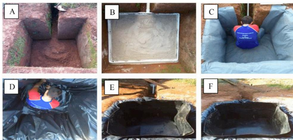
**Figura 1** – Características físicas do lisímetro: A - dimensões (1m<sup>3</sup>); B - rede coletora de lixiviado; C, D, E e F – impermeabilização.
